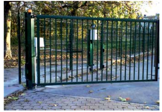
Portail battant un vantail d'un établissement scolaire
